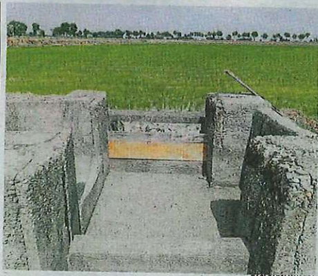
Canalizzazioni asciutte e le risale e restano senz'acqua
