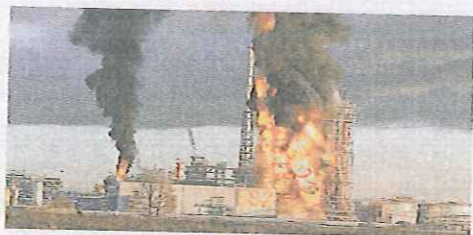
L'incendio che il primo dicembre 2016 ha danneggiato la raffineria
