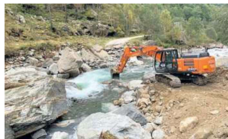
I lavori di ricostruzione ad Alagna sono già cominciati
