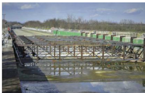
Nelle immagini, diverse fasi degli interventi che sono stati necessari per ripristinare il funzionamento del ponte-canale che fa attraversare al canale Cavour il torrente Cervo a Formigliana e, a fianco, i rilevatori installati per monitorare il manufatto
