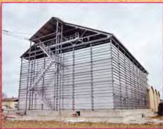
IMPIANTO DI STOCCAGGIO CON ESTRAZIONE AUTOMATICA DA TON 7000
