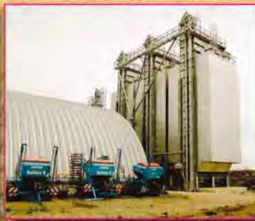
IMPIANTO DI ESSICCAZIONE PNEUMATICO ANTIPOLVERE. RISO A RICICLO DA TON 240
