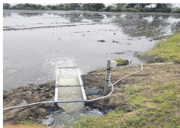
Misuratore del flusso idrico in ingresso a una camera dell'azienda Agricola Cerino
