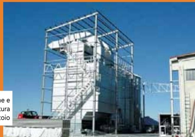
Impianto di essiccazione e stoccaggio con struttura di copertura essiccatore
